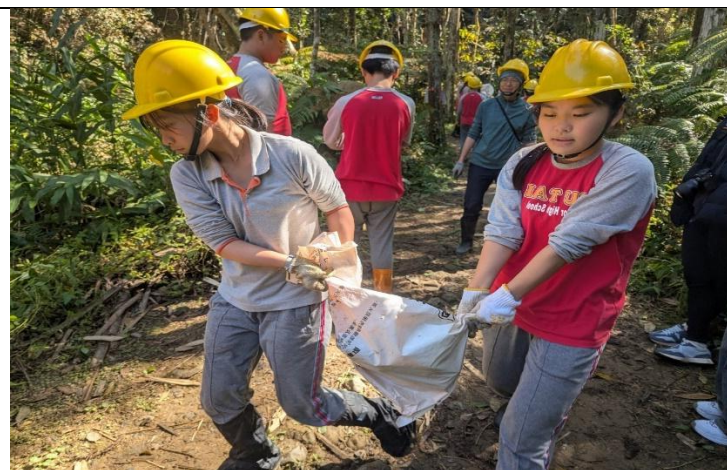
活動名稱：澀水步道修築及鋪設
