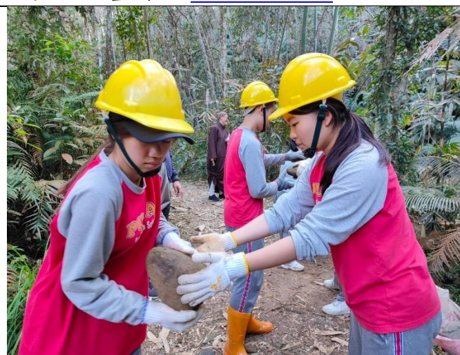
活動名稱：澀水步道修築及鋪設
