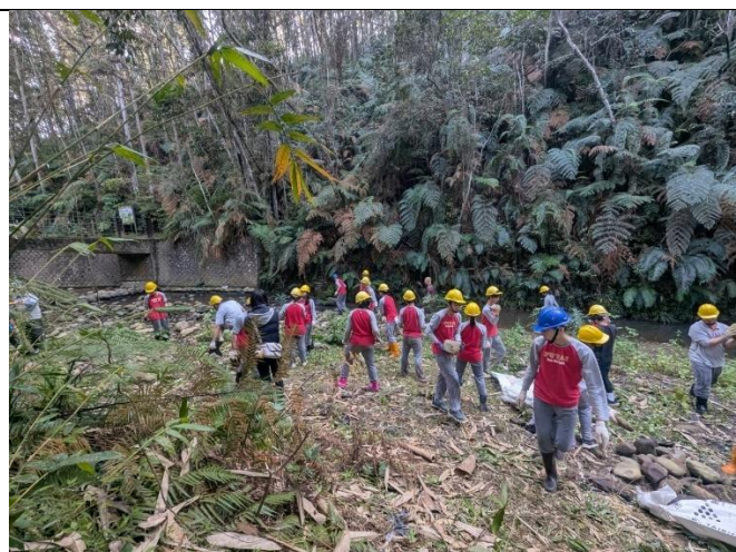
活動名稱：澀水步道修築及鋪設
