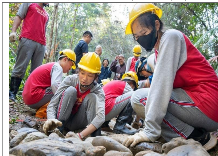
活動名稱：澀水步道修築及鋪設
